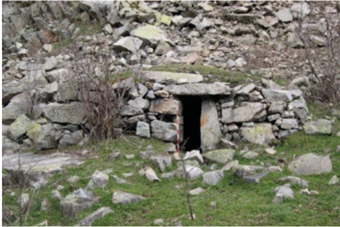
Cabana de Fontverd. Té gravada una data del darrer quart del segle XIX i la coberta és feta amb grans blocs de pedra.
