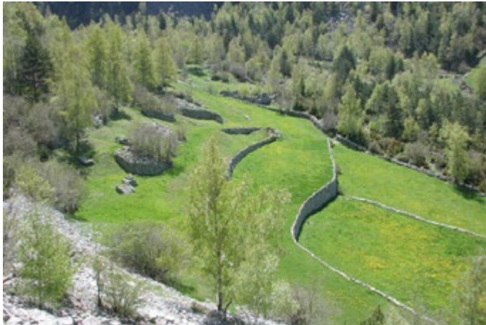
A l'esquerra de les feixes es poden observar una sèrie de despedregaments.
