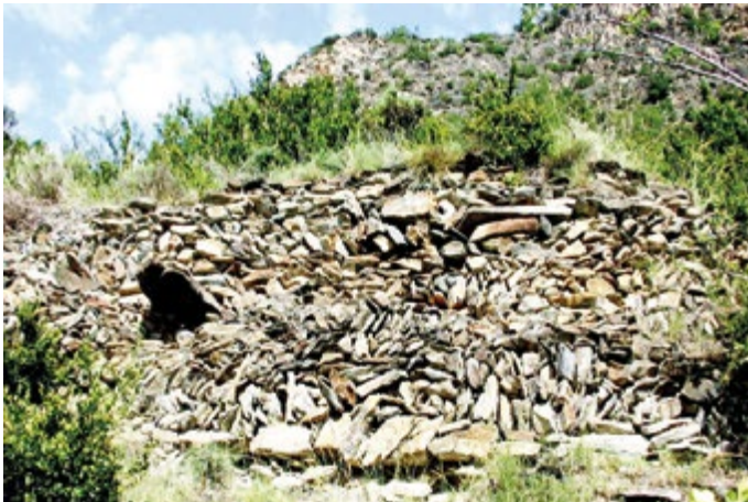
Marge amb part del parament construït en rastell.
