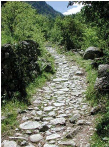
Camí de la Muntanya, amb el paviment "gravat" i mur de tanca.
