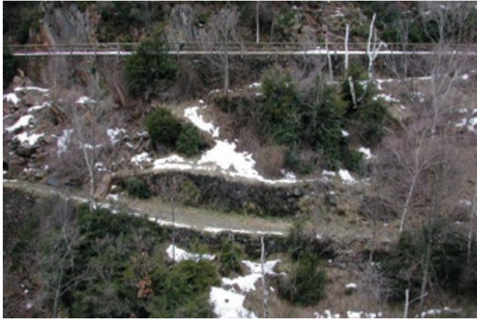
Terraplè i mur de contenció en el tram del camí Ral entre Andorra la Vella i la Massana.
